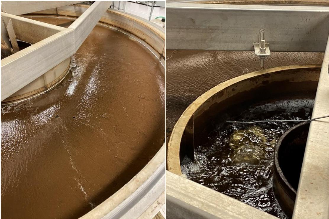
*Fig.1 et 2 vues sur le DAF*
