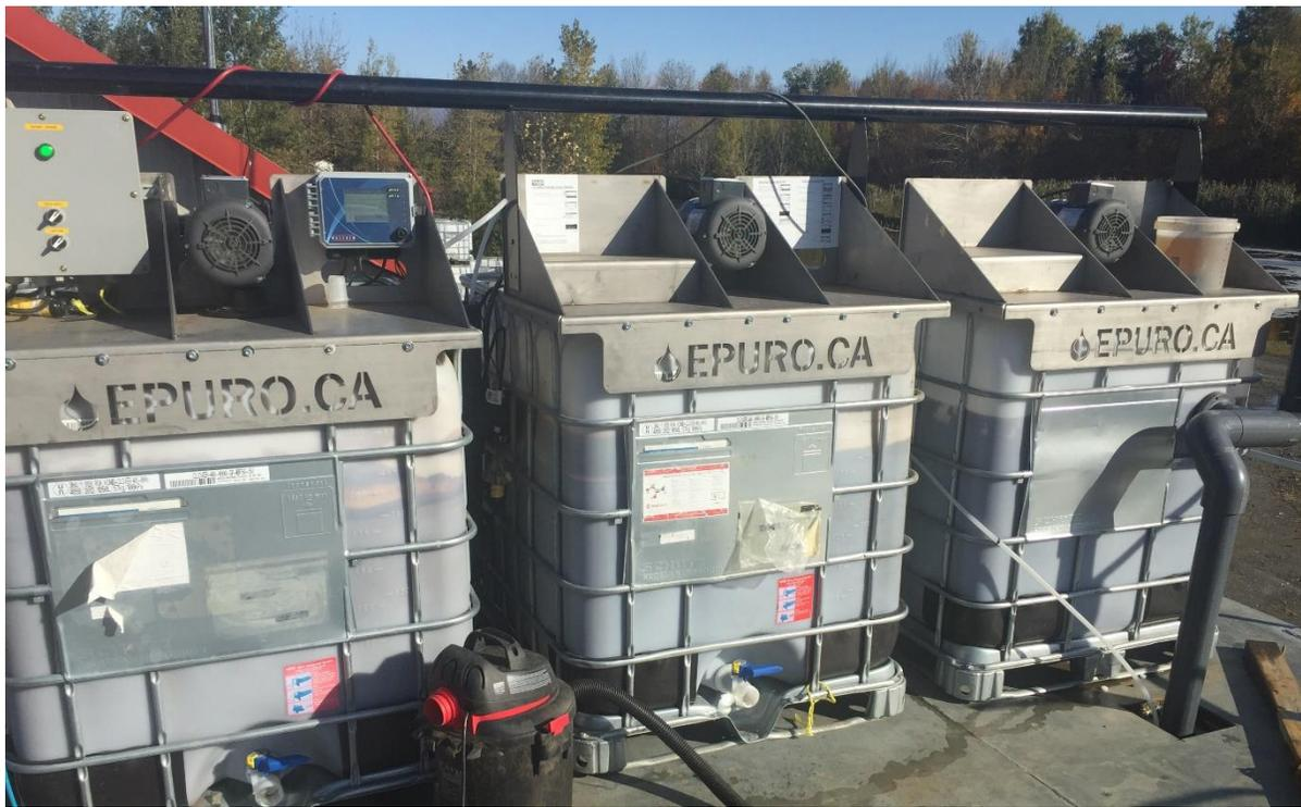
**Fig. 1 : Nouveau système d'injection des chimiques avant le décanteur**
